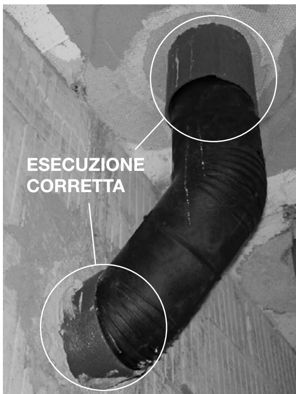
A) disaccoppiamento realizzato con guaina isolante Geberit.
