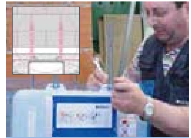
Montaggio delle staffe di fissaggio
