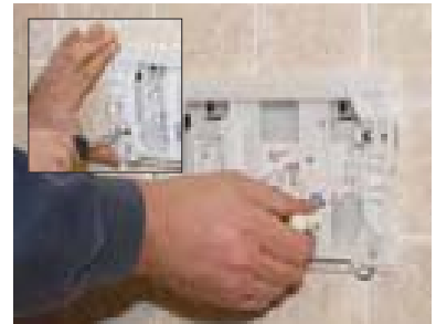
Fissaggio del telaio porta placca Inserimento dei perni di comando
