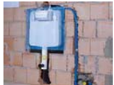
Cassetta pronta per l'intonaco
