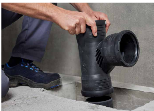
Innesto di una braga Silent-Pro Carve sulla curva BottomTurn al piede di colonna.
