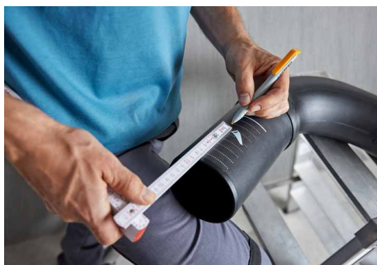
La curva Silent-Pro BottomTurn può essere facilmente adattata allo spessore della soletta.
