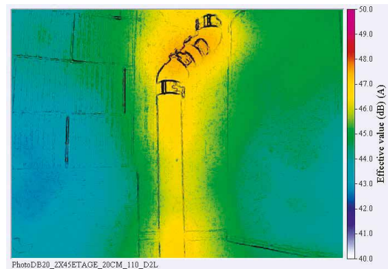
↑ Colonna di scarico con due braghe a 45° in media +9 dB(A)
